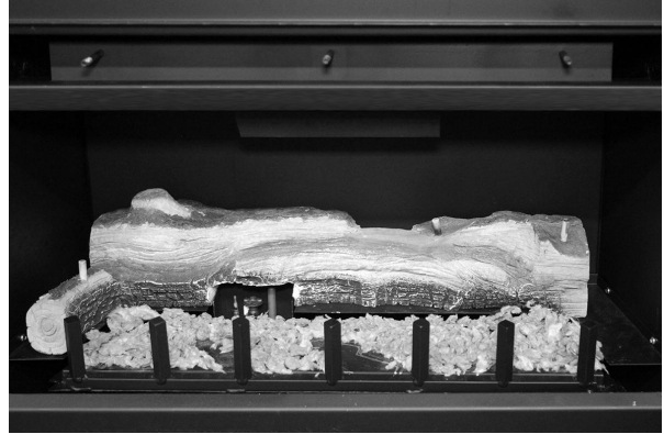
Figure 18 – Installation de la bûche de base gauche #2
